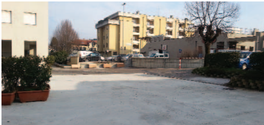
Piazza delle Tessitrici - Opere di Deimpermeabilizzazione
