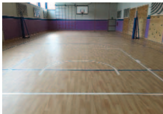
Palestra scuole medie Nazario Sauro Rifacimento pavimentazione
