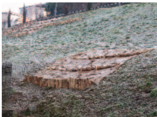
Cimitero di Malnate - Messa in sicurezza scarpata
