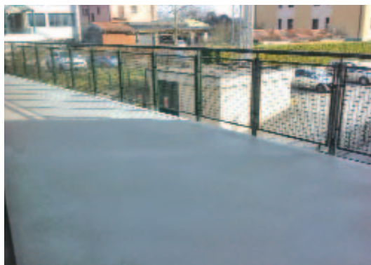
Palazzetto dello sport Realizzazione pavimentazione terrazze
