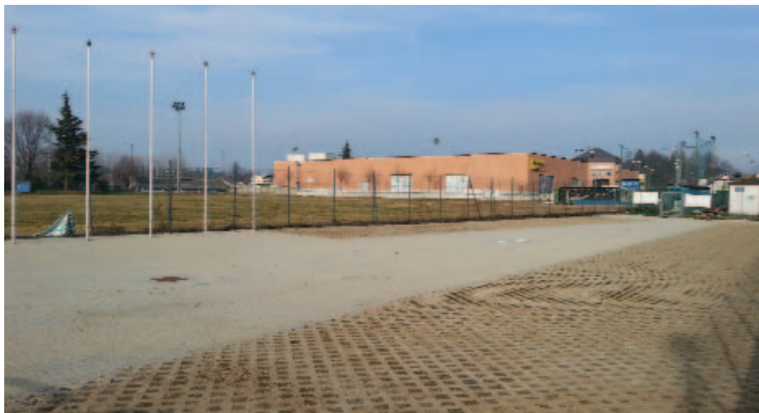
Parcheggio di via Mons. Sonzini - Opere di Deimpermeabilizzazione
