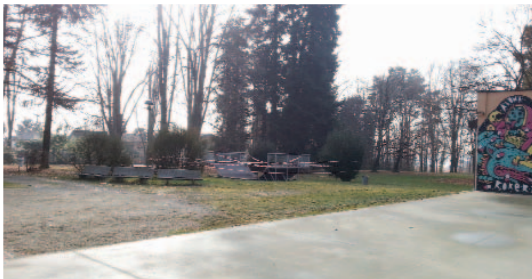
Parco Primo Maggio - Posa rampa skate
