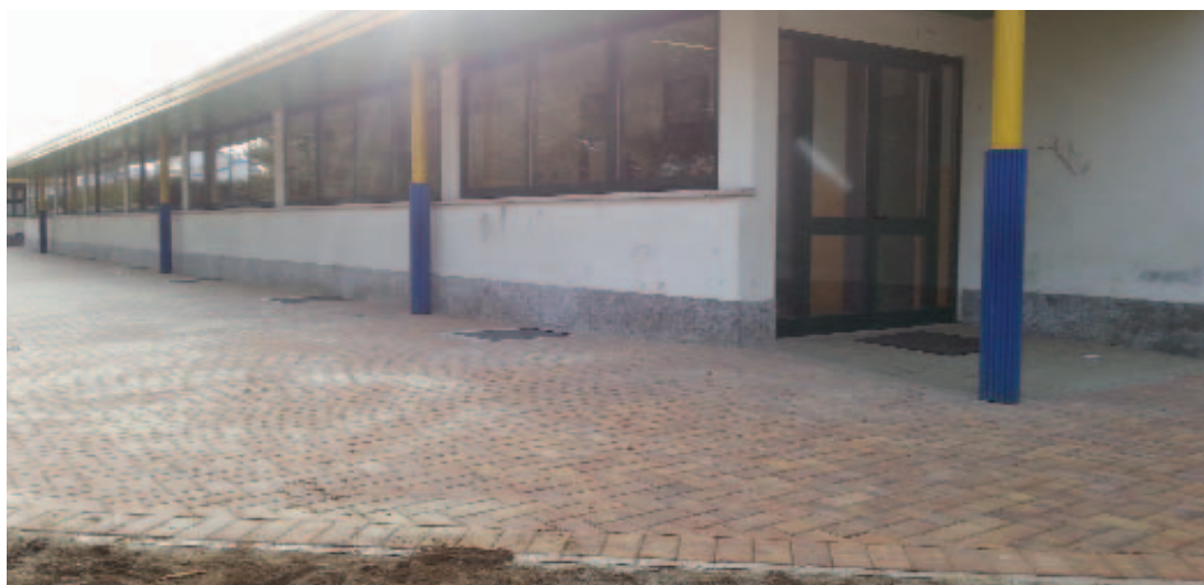
Cortile scuola Galbani, S. Salvatore - Opere di Deimpermeabilizzazione
