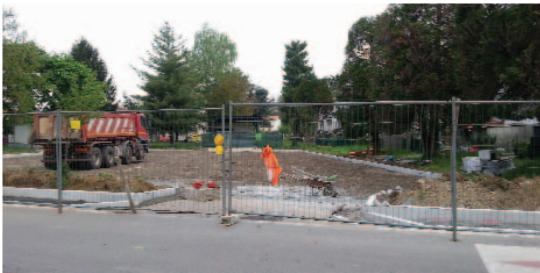
Piazza Salvo D'Acquisto - Opere di Deimpermeabilizzazione
